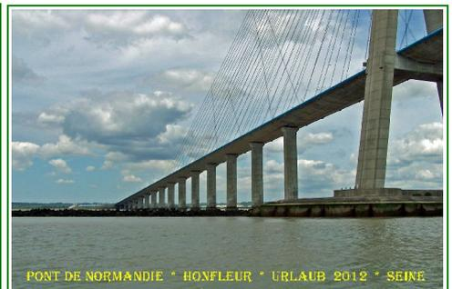
Die Schrägseilbrücke, die mit 856m die größte Spannweite in Europa besitzt überquert die Seinemündung und verbindet *Le Havre* (Haute-Normandie) auf dem rechten Ufer im Norden mit *Honfleur* (Basse-Normandie) auf dem linken Ufer im Süden. Die Brücke wurde in den Jahren 1988 bis 1994 gebaut. Insgesamt hat der 21,2m breite Brückenzug eine Länge von 2141,25m. Die Überführung in eine Richtung kostet 5,20€ für einen PKW.
